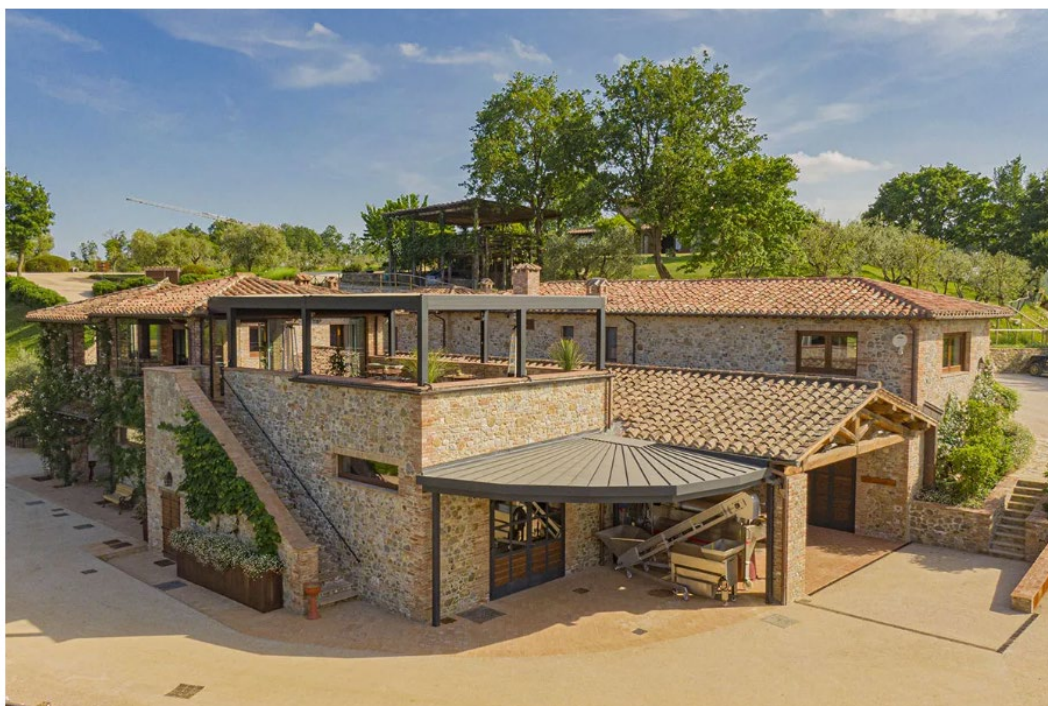
La struttura della Cantina Pomario
